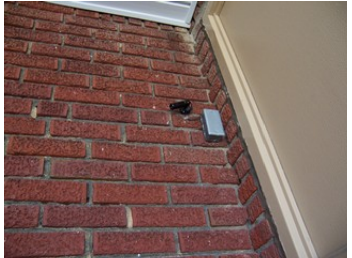
Front Door CCTV
